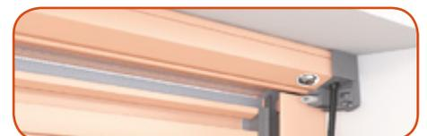
Regolare la carica della molla inserendo l'accessorio esagonale in un avvitatore elettrico ed agire nel foro posto nella testata riportante l'adesivo con la "chiocciola".
