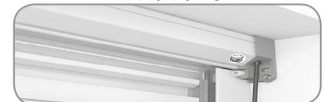
Regolare la carica della molla inserendo l'accessorio esagono in un avvitatore elettrico ed agire nel foro posto nella testata riportante l'adesivo con la "chiocciola".
